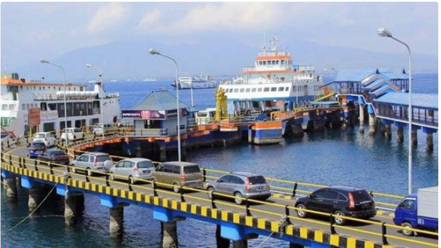
Pelabuhan penyeberangan Ketapang Banyuwangi
